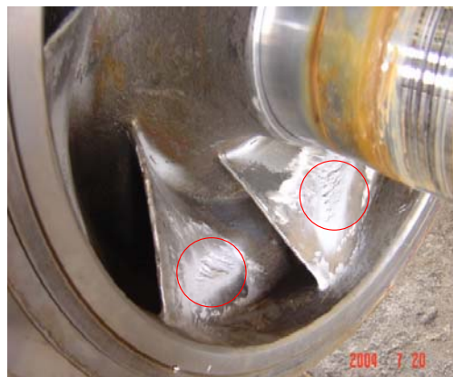
خوردگی پره های طرف مکش یک پمپ کولینگ
